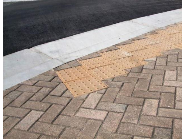
図1: FRC用途(強化繊維コンクリート製品事例、各種敷石) 歩道敷石、建築物の外壁モルタル、側壁補強モルタル(土木)、床モルタル、タイル・石下地モルタル、他土壁など
